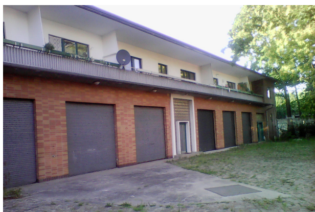
Das nur zweistöckige Lager-/Wohnhaus der Berliner Wasserbetriebe
